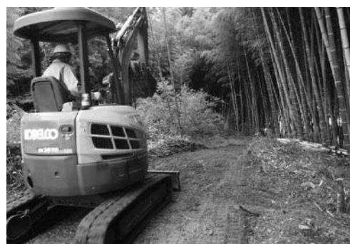
作業道の整備
