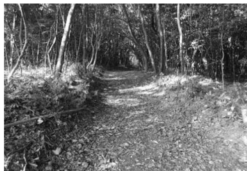
除伐、拡幅して整備した林内作業道
